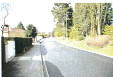
Réfection de voirie effectuée boulevard des Océans
