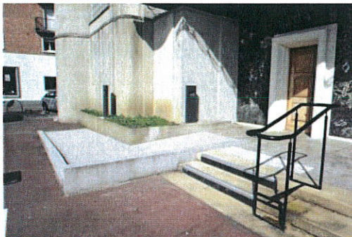
Mise en accessibilité de l'église Saint-Pierre Saint-Paul
